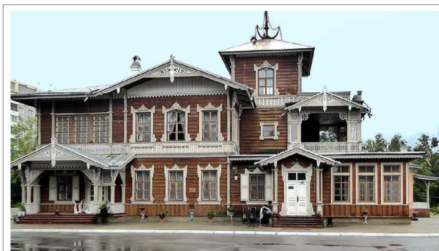
Anwesen des Irkutsker Bürgermeisters Wladimir Sukatschow (1880)
